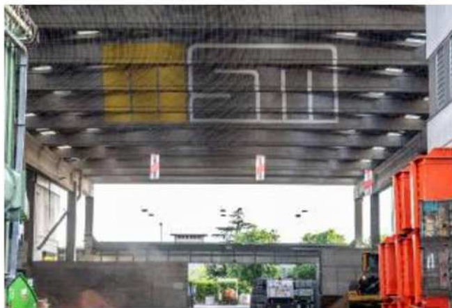
Un'immagine dell'installazione all'interno dello stabilimento di Calcinato
